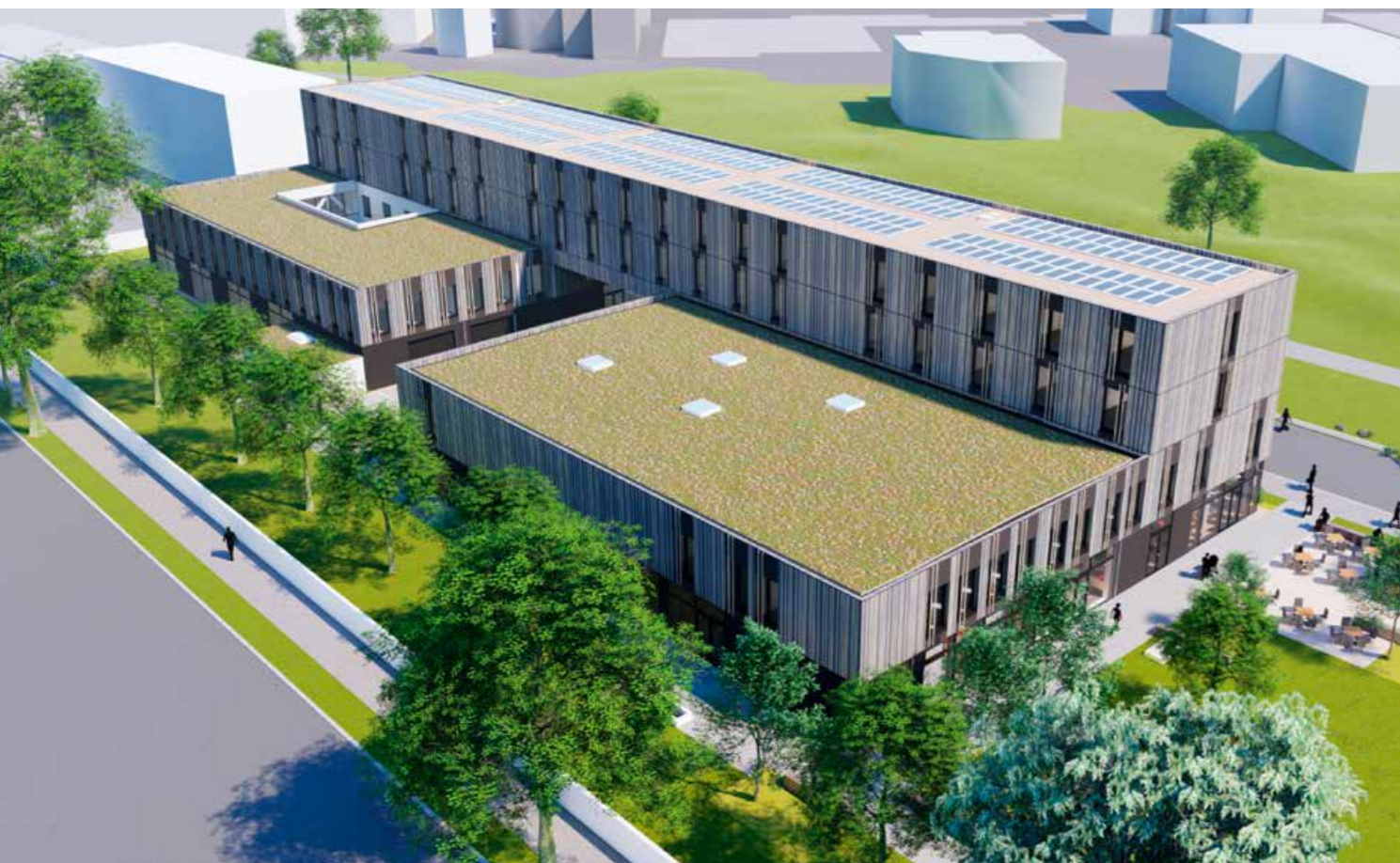
▼ Die 1000 m 2 große Photovoltaikanlage auf dem Dach des Hotels deckt einen Teil des Strombedarfs
